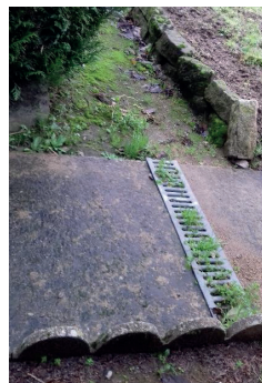
Piège à eau , pour canaliser l'eau sur sa course.
