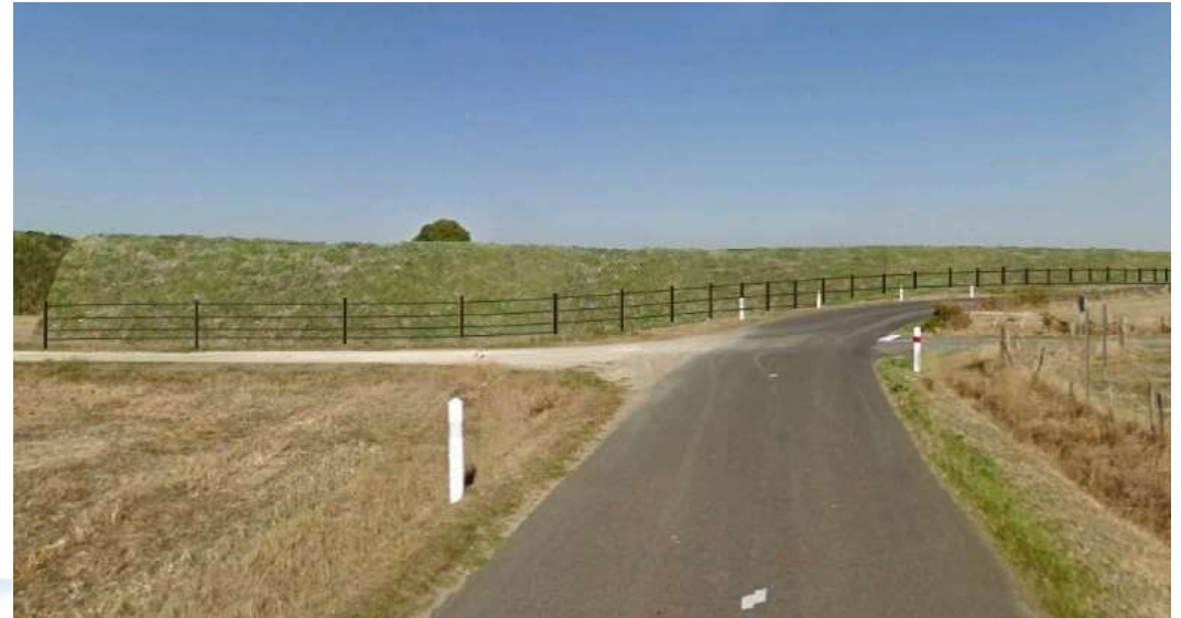
Montage photographique de la réalisation du merlon au niveau de l'ilot Nord
