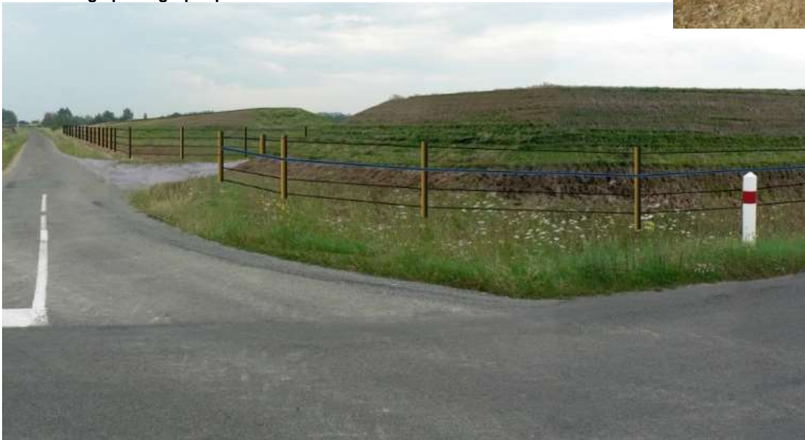
Montage photographique de la réalisation du merlon au niveau de l'ilot Sud.
