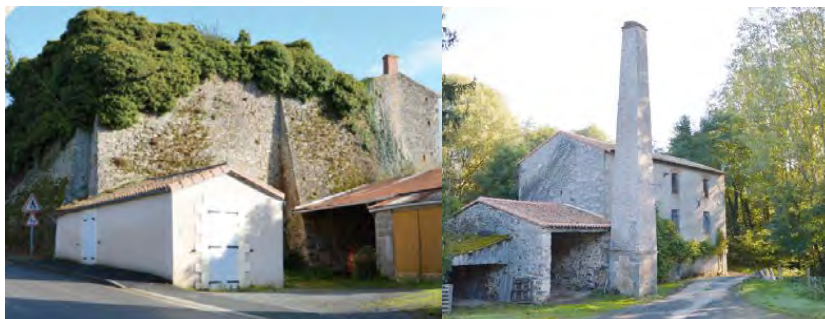
Four à chaux et Moulin de Veillet, tous les deux à Glénay – Saint-Varentais Patrimoine industriel – Service de l'Architecture et des Patrimoines – 2013
