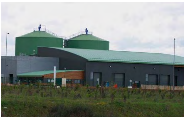
TIPER Méthanisation, implanté sur la zone industrielle de Louzy à Thouars Crédit photo : La Nouvelle République
